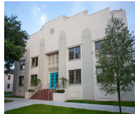
131 S. Jefferson Davis Pkwy.
